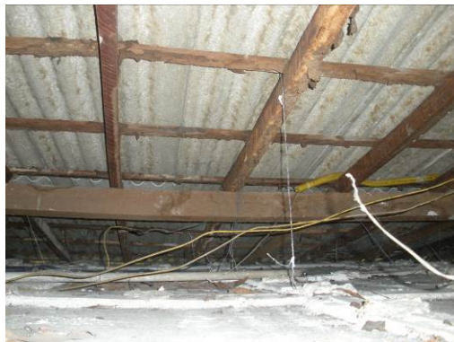
Foto 63: Cabeamento solto, sem proteção;
