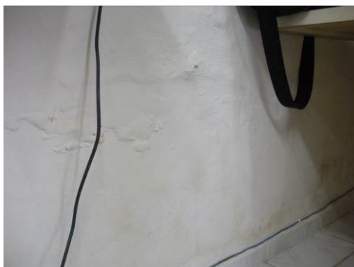
Foto 35: Umidade em alvenarias.
