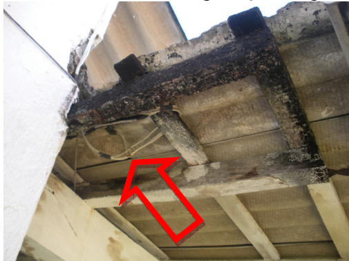
Foto 61: Cabeamento na estrutura da cobertura com parte sem capeamento, que pode ocasionar curto circuito;
