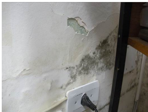
Foto 38: Infiltração em alvenaria;
