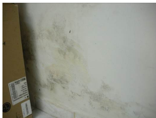
Foto 36: Umidade em alvenarias.
