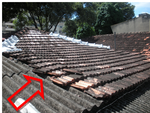
Foto 56: Utilização de Sistemas Incompatíveis De recobrimento em uma mesma coberta;
