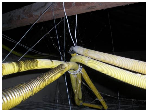
Foto 65: Cabeamento protegido, porém mal fixado e organizado;
