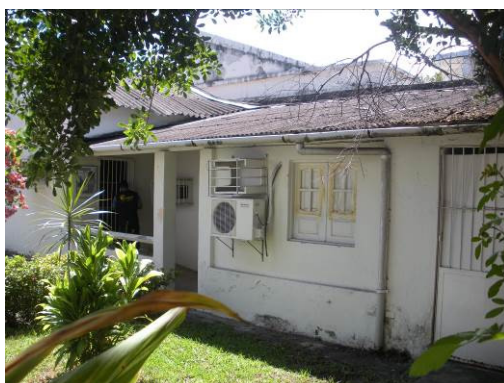
Foto 25: Vista do Anexo.
