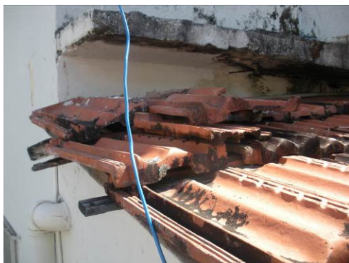
Foto 44: Deslocamento de telhas;
