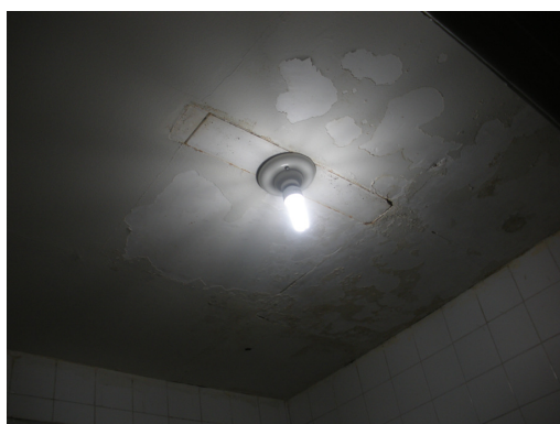
Foto 49: Infiltração de água no teto;
