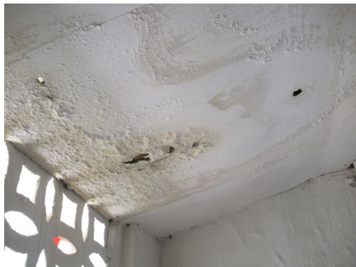
Foto 48: Infiltração de água no teto;
