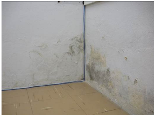
Foto 34: Umidade em alvenarias.
