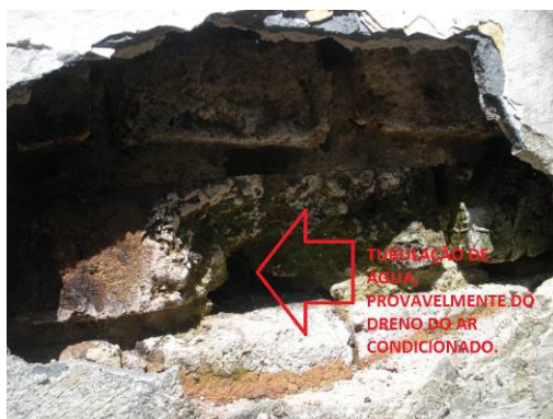
Foto 37: Infiltração em alvenaria;
