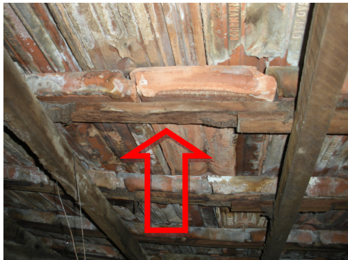
Foto 40: Perda de seção das ripas pela Ação dos cupins;
