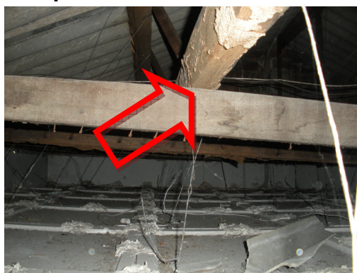
Foto 42: Perda de seção nas terças;
