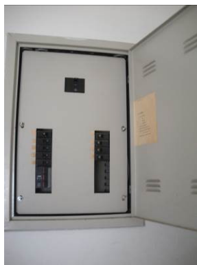
Foto 59: Necessidade de medição dos disjuntores para averiguar sobre o atendimento das normas técnicas.
