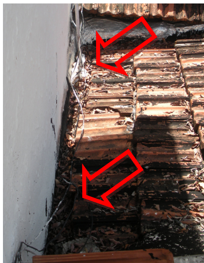
Foto 57: Acumulo de sujeira nas calhas;
