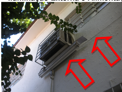
Foto 68: Cabeamento desprotegido e solto pela fachada e luminária inadequada para iluminação externa, sendo recomendado utilização de refletores;
