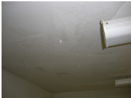
Foto 47: Infiltração de água no teto;
