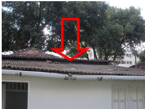
Foto 51: Deformação da cobertura;
