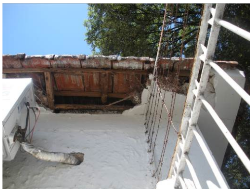
Foto 32: Destacamento do revestimento em Beiral.
