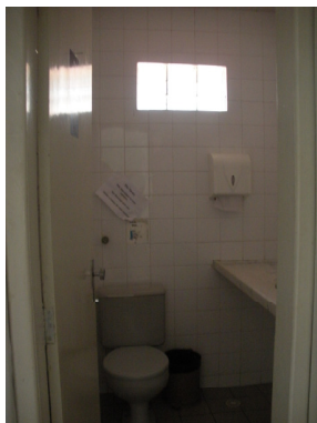
Foto 23: Vista do Banheiro Masculino.
