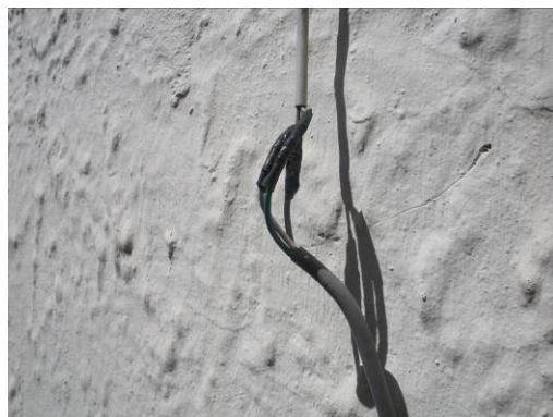
Foto 60: Cabeamento solto na fachada de Alimentação das unidades condensadoras;
