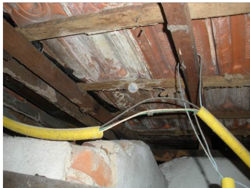
Foto 64: Cabeamento solto, parte protegida por eletroduto flexível corrugado e parte desprotegida;
