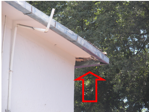
Foto 33: Destacamento do revestimento em Beiral.
