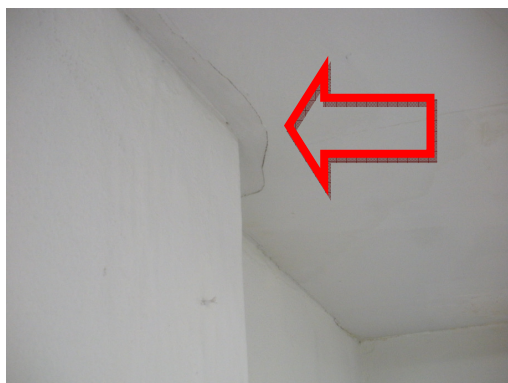
Foto 54: Fissura e deformação do forro;
