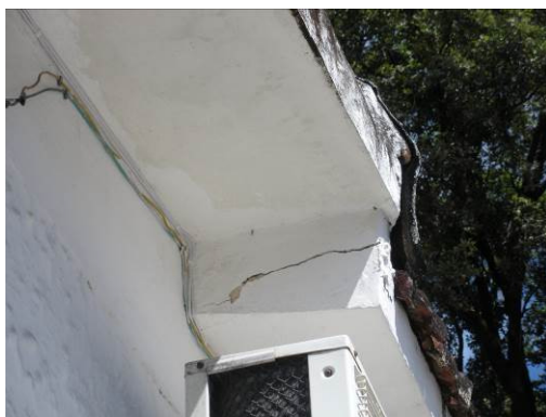
Foto 31: Identificação de Fissura em Beiral.
