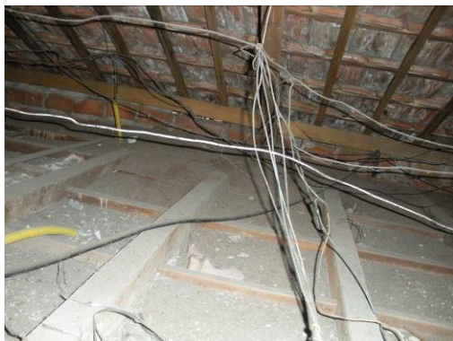
Foto 62: Cabeamento solto, sem proteção;
