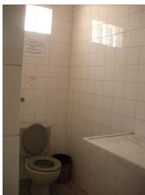
Foto 24: Vista do Banheiro Feminino.
