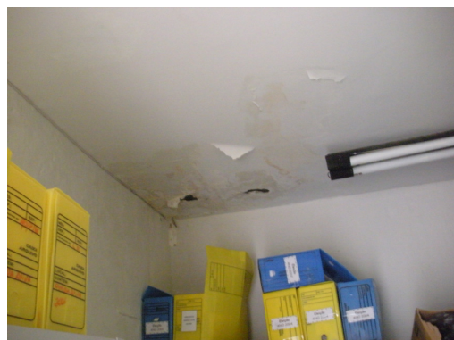
Foto 46: Infiltração de água no teto;
