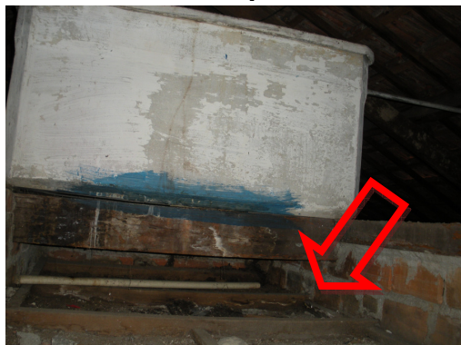
Foto 66: Identificação de vazamento pelo Reservatório superior;
