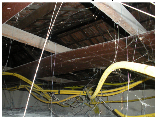
Foto 66: Cabeamento mal fixado, com parte protegido e parte desprotegido;
