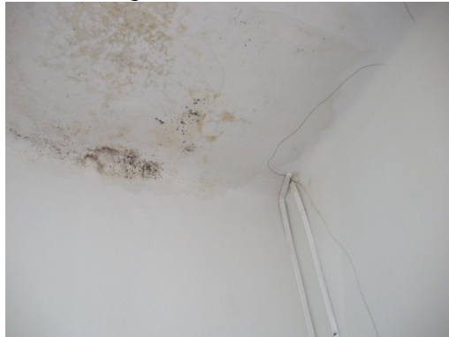
Foto 50: Infiltração de água no teto;
