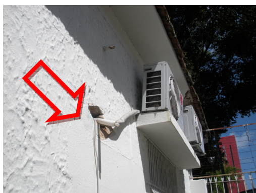
Foto 68: Identificação de dreno aparente sem previsão de caixa de infiltração;
