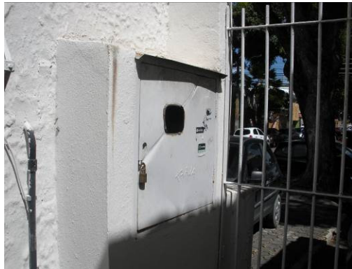
Foto 58: Medidor fora de norma, pois, está localizado dentro da edificação, quando deveria estar do lado de fora.
