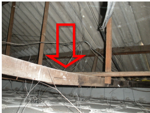
Foto 52: Fissura em elementos da estrutura da cobertura, que podem levar ao colapso dos elementos da cobertura;
