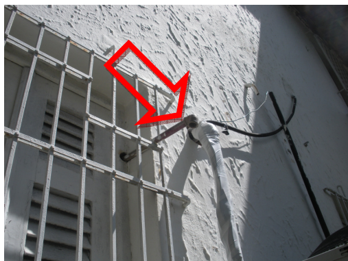
Foto 67: Identificação dreno aparente sem previsão de caixa de infiltração;
