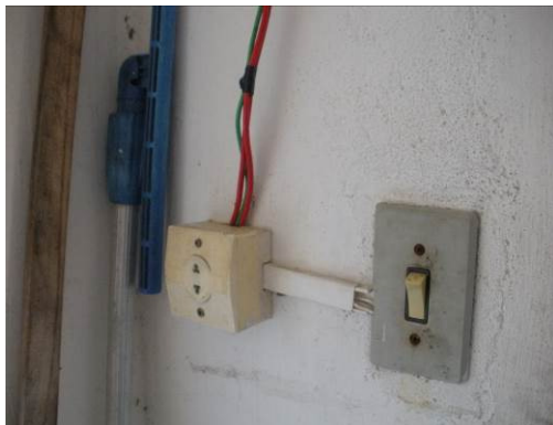
Foto 67: Cabeamento desprotegido e tomada fora de norma;
