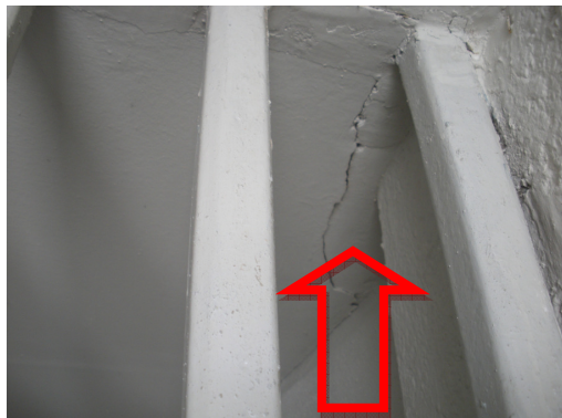
Foto 55: Fissura no forro;
