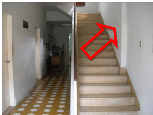
Foto 68: Ausência de corrimão em uma das laterais da escada, conforme exigência do CBMPE;
