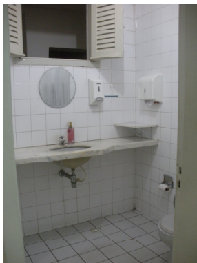
Foto 16: Vista do Banheiro Feminino.
