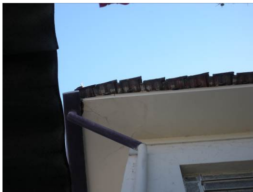
Foto 30: Identificação de Fissura em Beiral.
