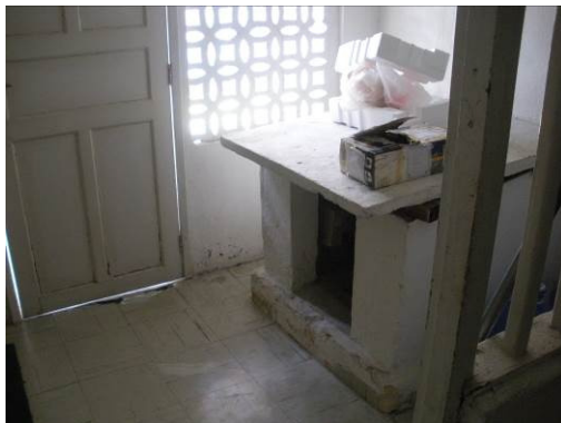
Foto 17: Vista Casa da Bomba.
