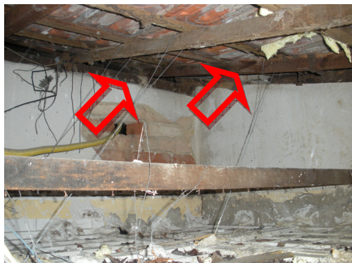
Foto 53: Fixação de tirantes em caibros;
