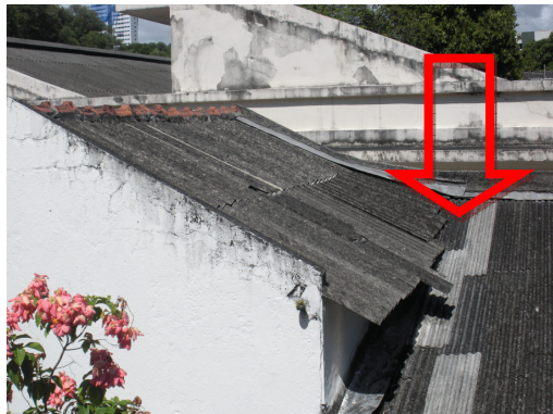
Foto 45: Deslocamento de telhas;
