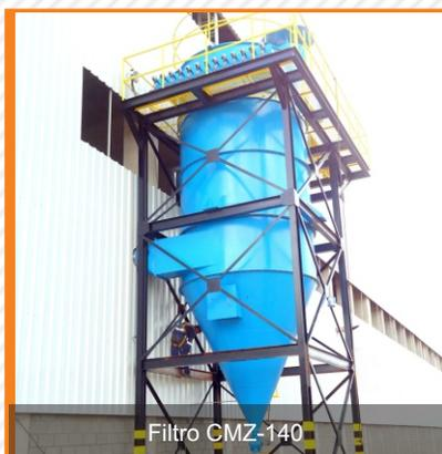
Filtro de mangas é um equipamento que tem por objetivo exaurir o ar contaminado proveniente das operações industriais e separar o material particulado por meio de mangas de filtragem, obtendo-se um ar dentro dos padrões de emissão, com possibilidade de reaproveitamento do material.
